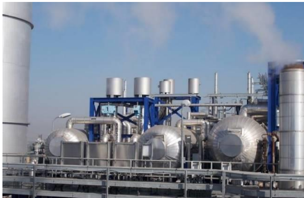
รูปที่ ข.3-1 การติดตั้งชุดลดเสียง (Silencer)
